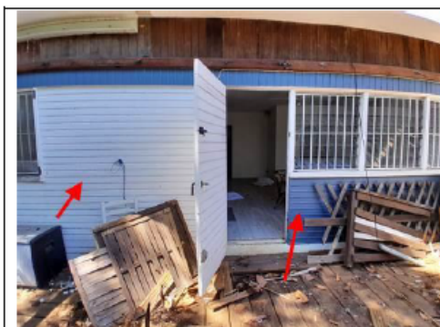
Photo n° PhPb004 Localisation : Maison 1 UD : Façades (avant et arrière) (mesure 1) Type de dégradation : NC - Substrat : métal - Revêtement : peinture bleu et blanc - Mesure : 1,3
